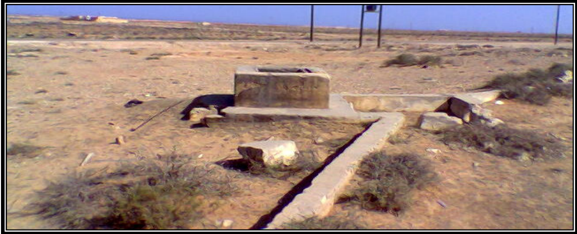
صورة رقم ( 35 ) ماجن لتجميع مياه الأمطار – وادي جارف .
