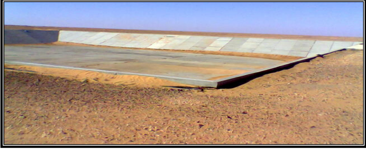
صورة رقم ( 34 ) خزان سطحي مكشوف – جنوب بوهادي .
